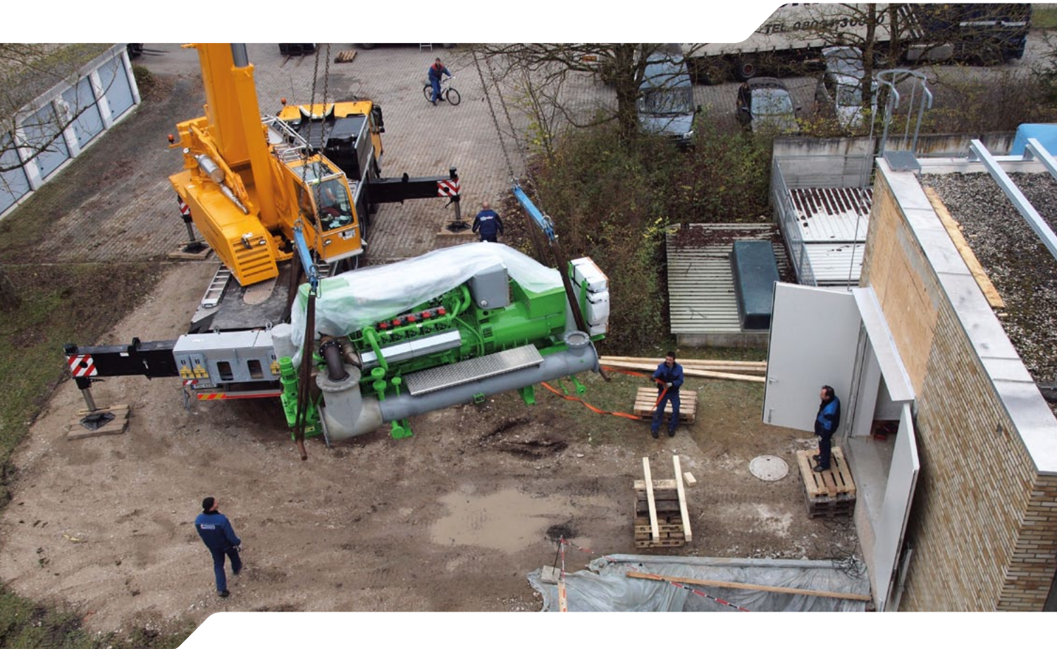
Einbau des Blockheizkraftwerks.
